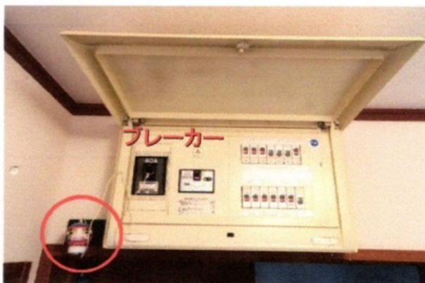
カバー分電盤取付方法
